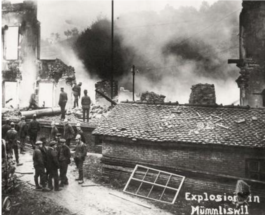
Die abgebrannten Gebäude der Kammfabrik am 1. Oktober 1915, am Tag nach der Explosion. Quelle: Zur Verfügung gestellt
